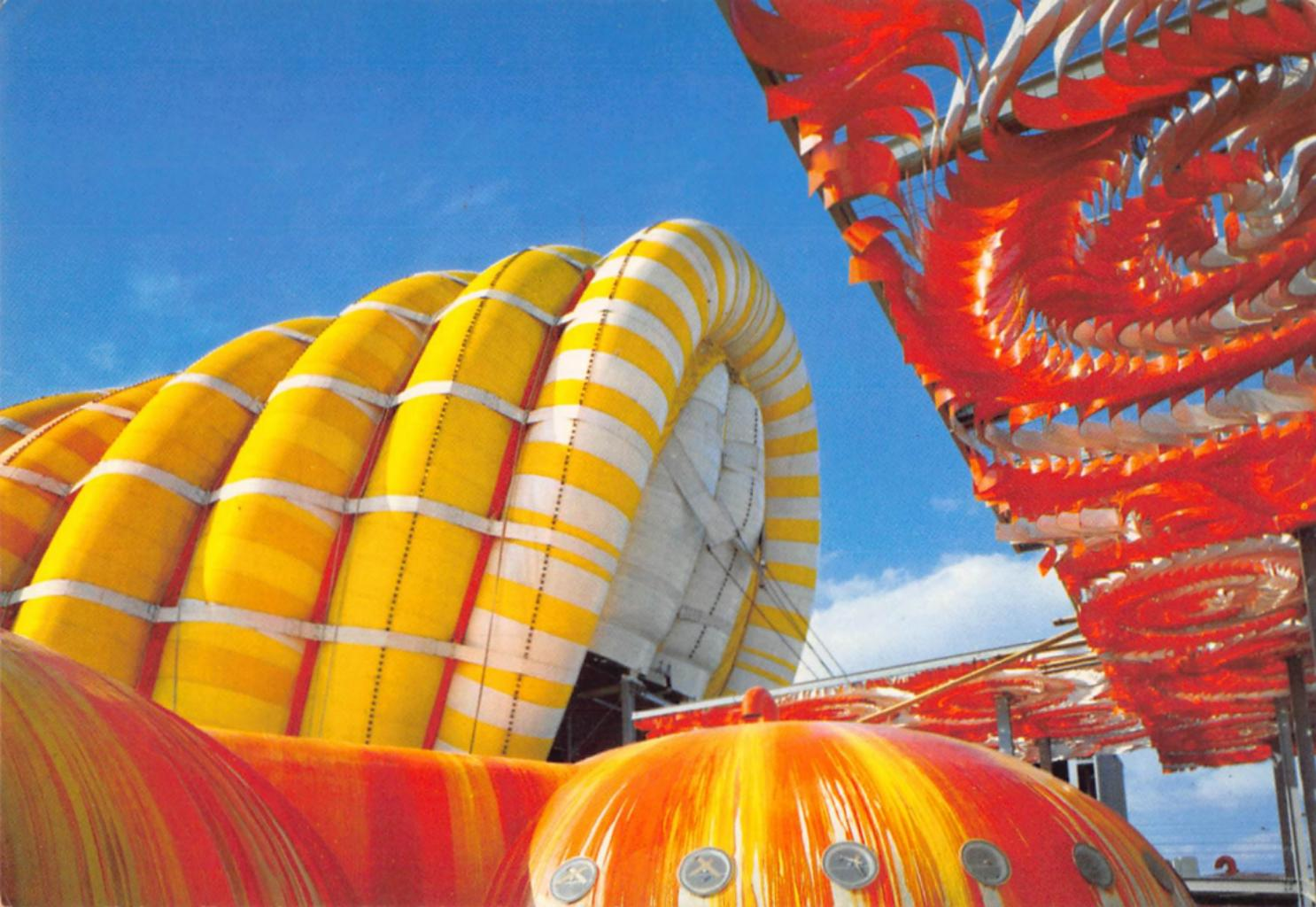
富士グループ・パビリオン 直径4 mの合成繊維のパイプに圧縮空気を吹き込んだ布と空気の建築で、10階建てのビルが中にはいるほどの大きさである。
