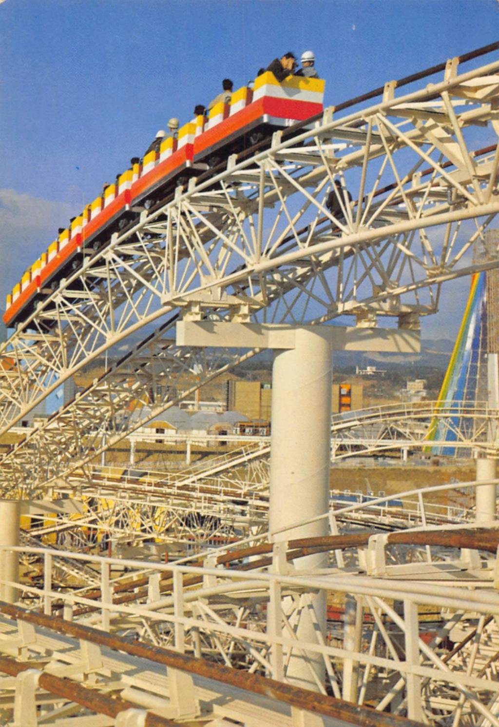
ダイダラザウルス 延長682～1186mの5つのコースを持つ巨大なジェット・コースターで時速40～65kmで錯覚、スリル、スピード等をたのしみ、同時に出発して同時に帰りつく設計になっている。
