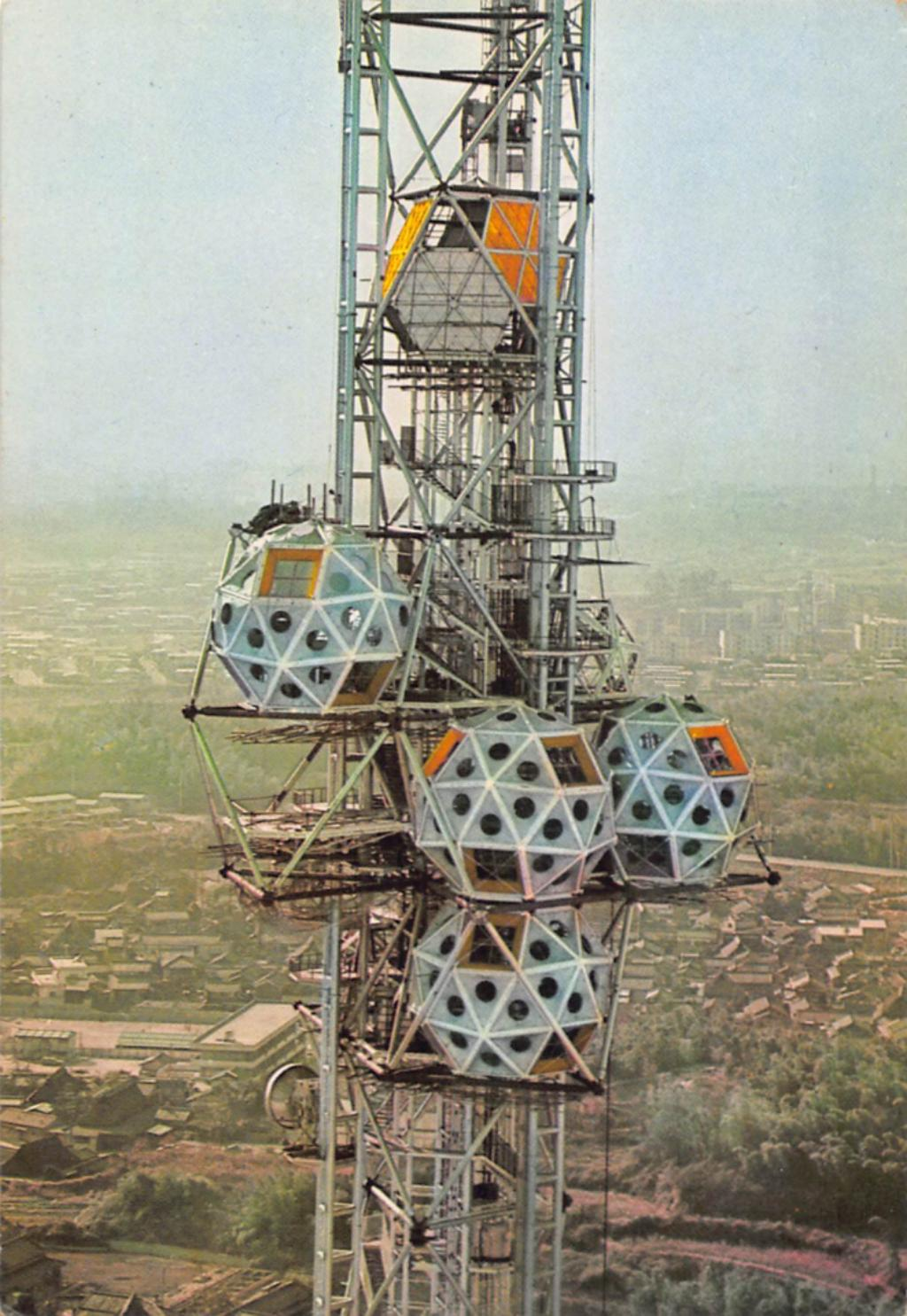
エキスポタワー 高さ127mの塔の上部には展望室や喫茶室、万国博の各種通信施設が設けられ、展望式の2台のエレベーターで昇降できる。この塔は基部が未広がりの東京タワーと違って、3本の軸柱で直ぐに立っている。
