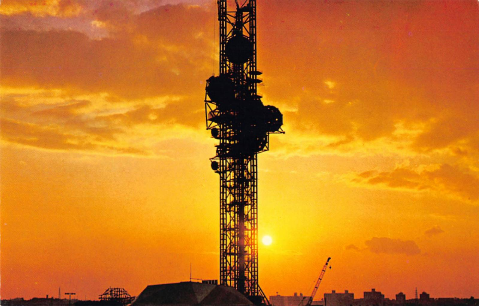
エキスポタワー 高さ124mの塔の上部には展望室や喫茶室、万国博の各種通信施設が設けられ、展望式の2台のエレベーターで昇降できる。この塔は基部が未完成の東京タワーと違って、3本の軸柱で直ぐに立っている。
