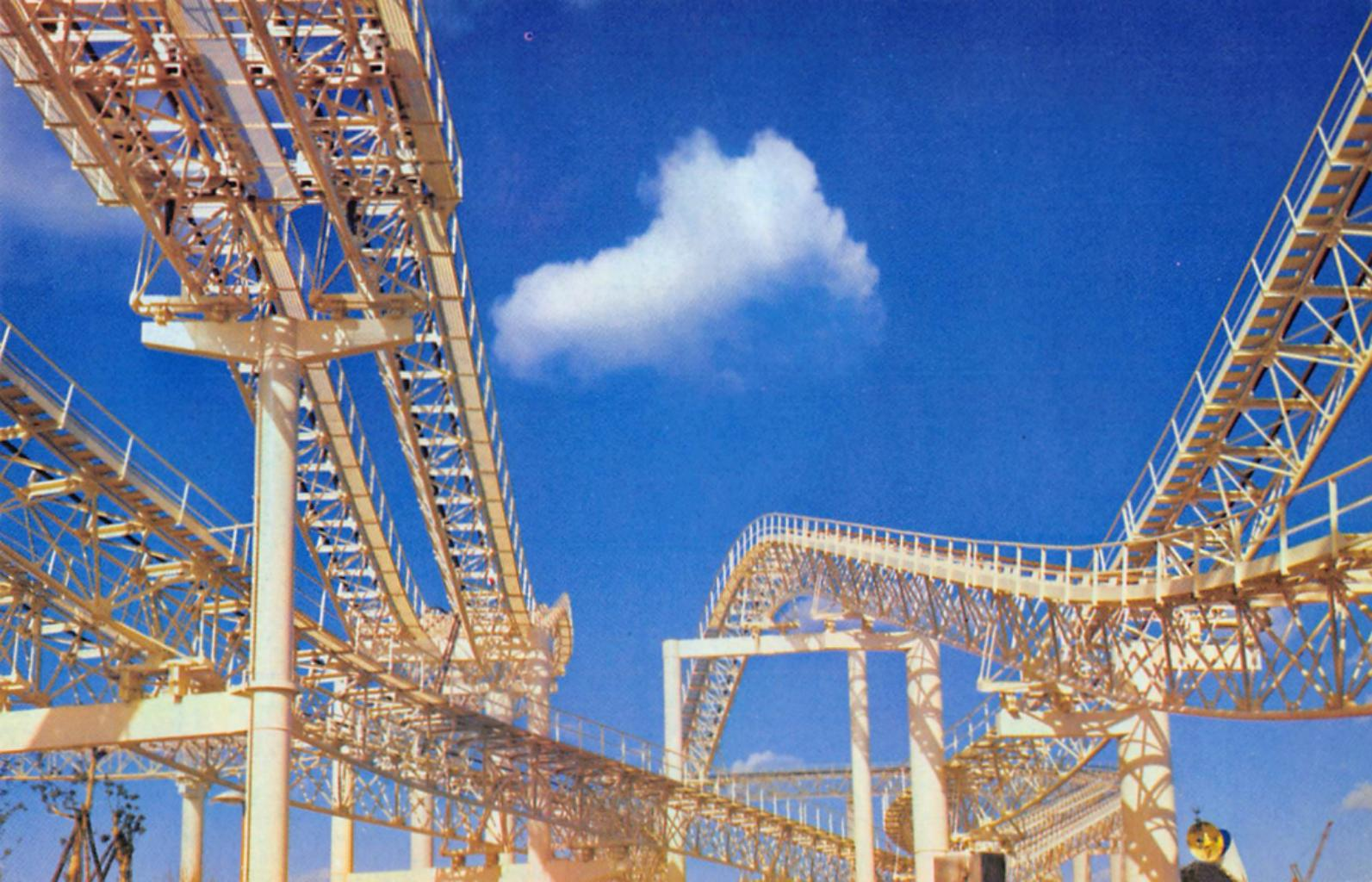
ダイダラザウルス 延長682~1186mの5つのコースを持つ巨大なジェット・コースターで時速40~65kmで錯覚、スリル、スピード等をたのしみ、同時に出発して同時に帰りつく設計になっている。
