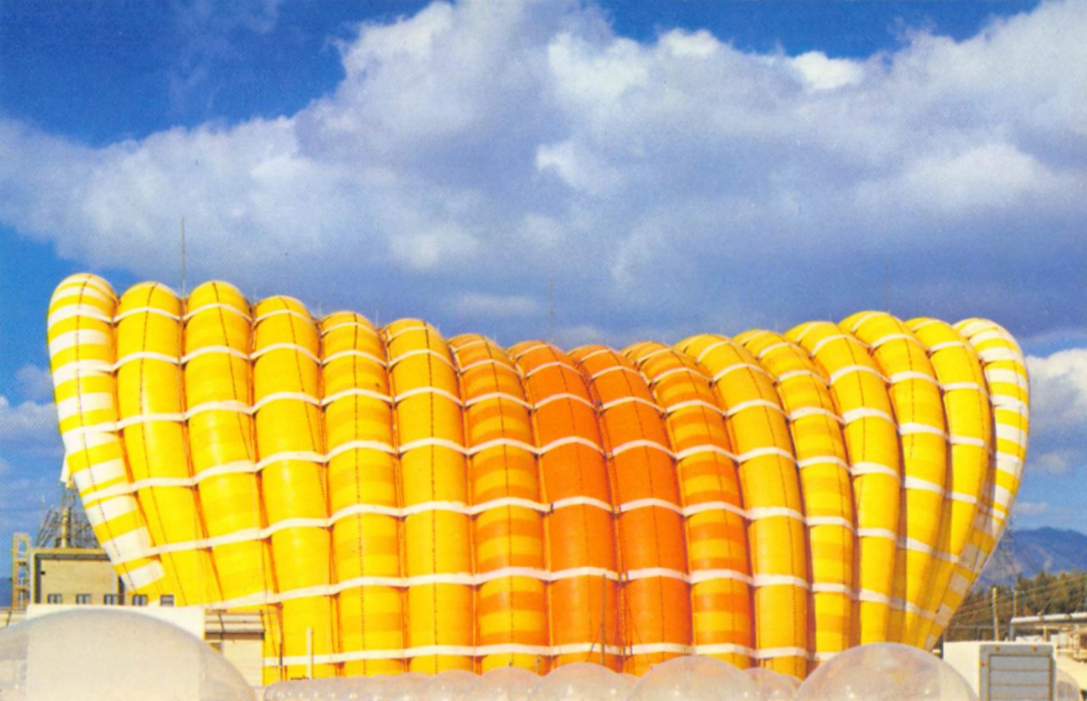
富士グループ・パビリオン 直径4 mの合成繊維のパイプに圧縮空気を吹き込んだ布と空気の建築で、10階建てのビルが中にはいるほどの大ささである。
